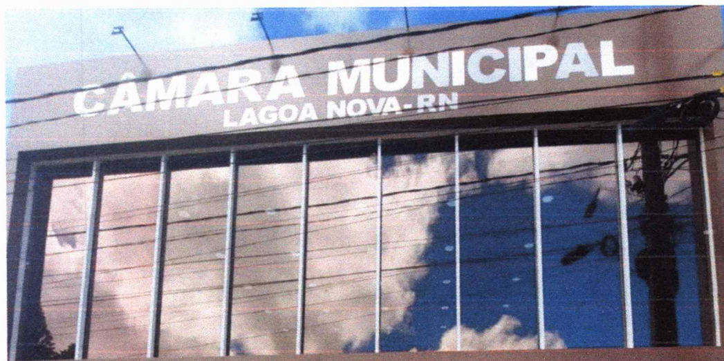
Figura 7 – Instalação de letreiro em aço inoxidável.
