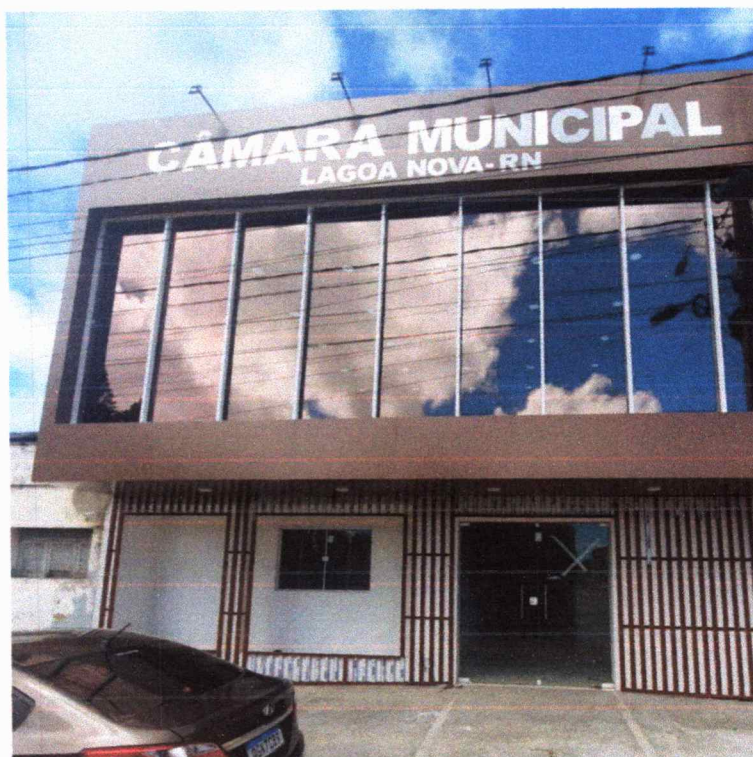
Figura 13 – Instalação de película de vidro.
