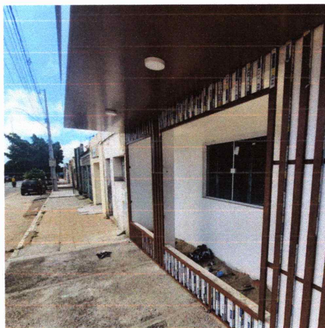
Figura 10 – Instalação de gradil na fachada e e aplicação de textura acrílica.
